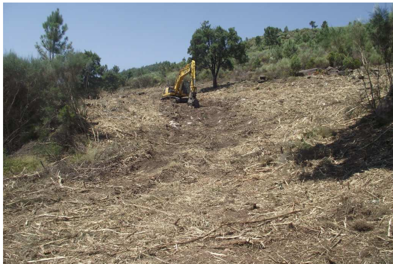
SET – Movimentação de terras para a passagem de máquinas na Escombreira 22B.
