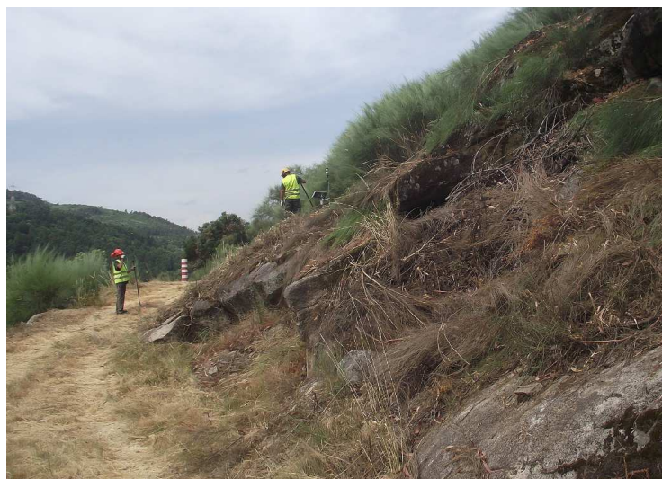
SET | Desenvolvimento dos trabalhos na área dos marcos geodésicos. Visto de este
