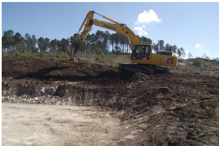
SET – Escavação para acerto dos taludes
