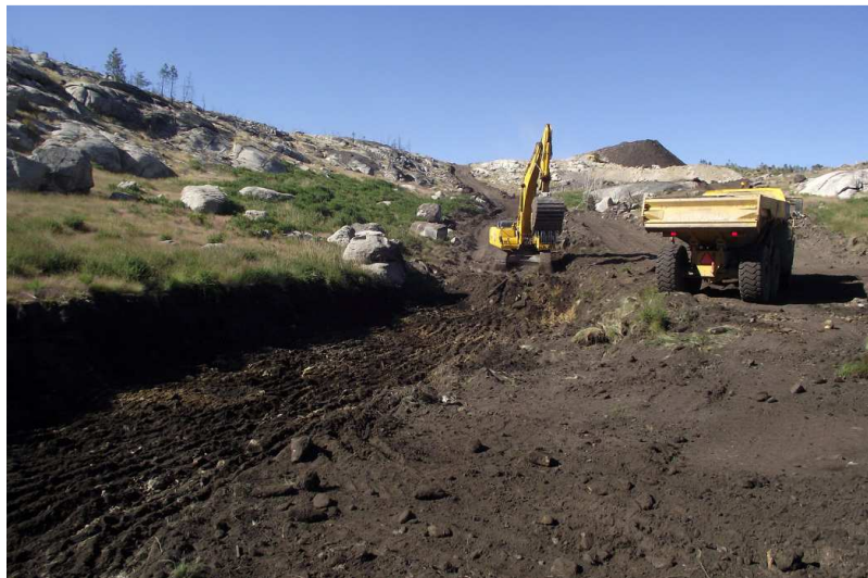
SET| Vista de sul da remoção de terras para a abertura de vala.
