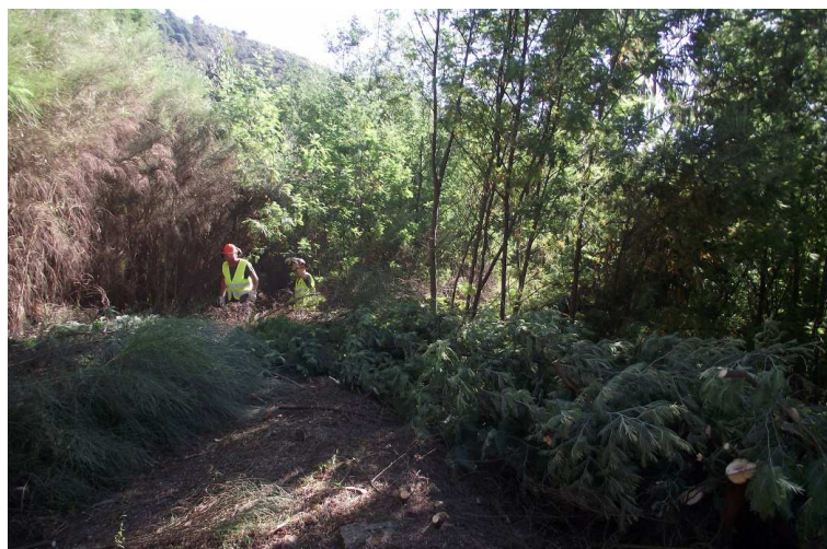
SET | Desenvolvimento dos trabalhos na área dos blondines de acesso à central.
