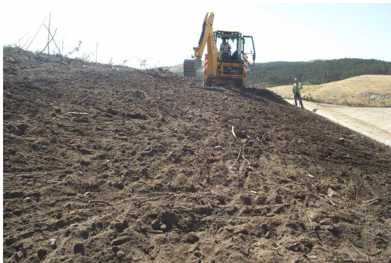
SET – Escavação para acerto dos taludes das plataformas.
