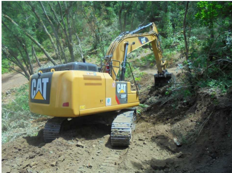
SET| Escavação mecânica no acesso C30, entre os PK 4+700 e PK 4+600.
