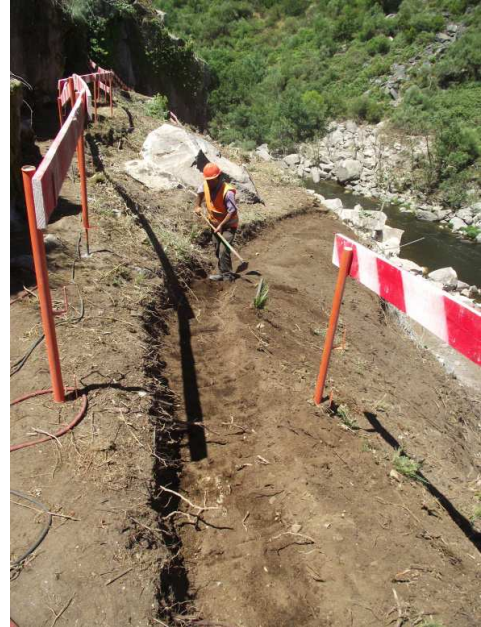
SET| Escavação da vala de crista na boca de entrada do túnel.
