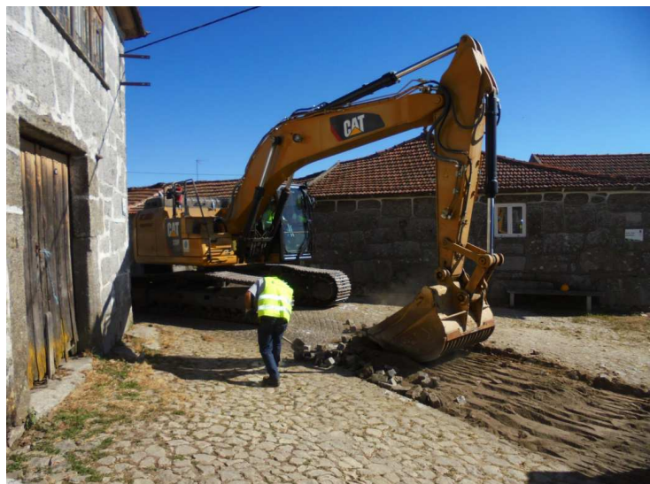
SET| Remoção de calçada de paralelo no acesso B30.
