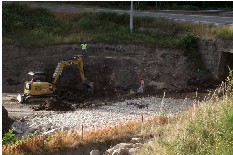
SET| Escavação mecânica no corte auxiliar da vala perimetral.
