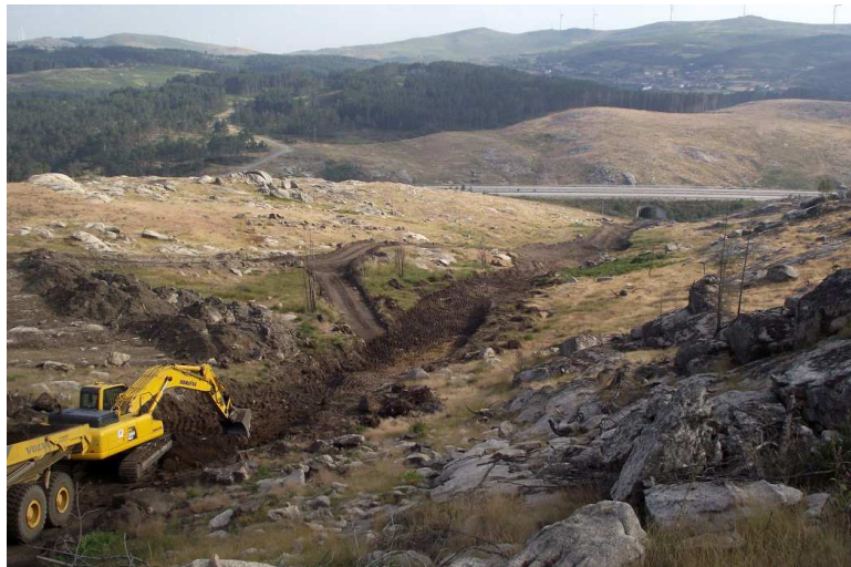
SET | Vista geral, de noroeste, da escavação para a vala do dreno.
