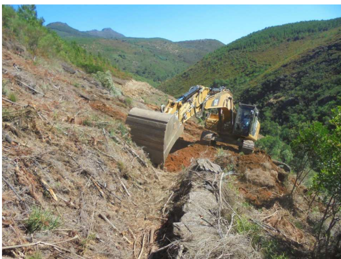
SET| Desmonte parcial do caminho murado (OP 249).
