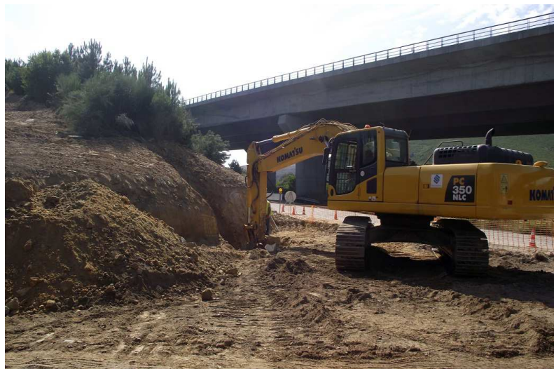
SET | Escavação da PH no Entroncamento EN206.
