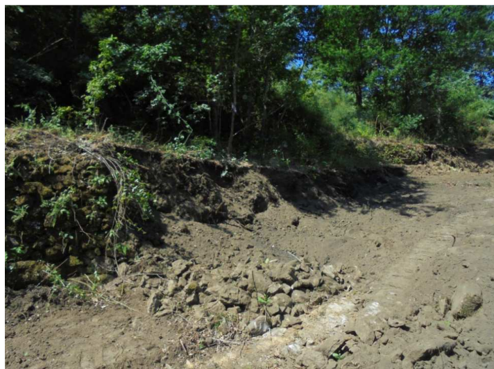
SET| Desmonte parcial de socalcos (OP 238).
