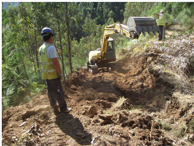
SET - Abertura do caminho de acesso ao AP 2B.
