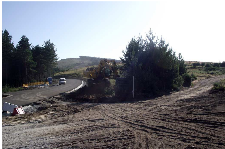
SET | Vista a sudoeste da escavação entre os PK0+180 – PK0+300 do B09.3.
