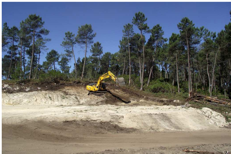
SET| Escavação junto à plataforma oeste.
