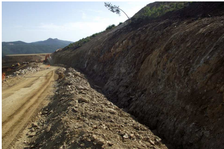
SET | Pormenor da vala na zona do PK1+100.
