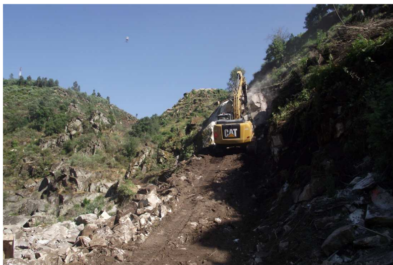
SET| Escavação mecânica na boca de entrada do túnel
