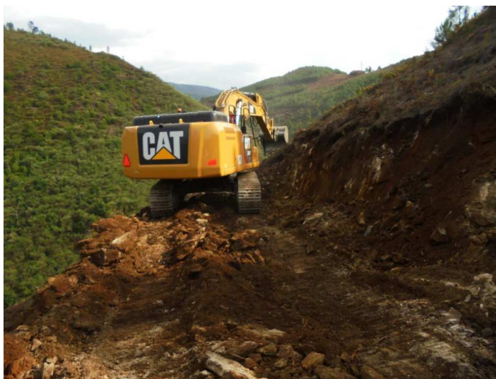
SET | Escavação mecânica no acesso C30.
