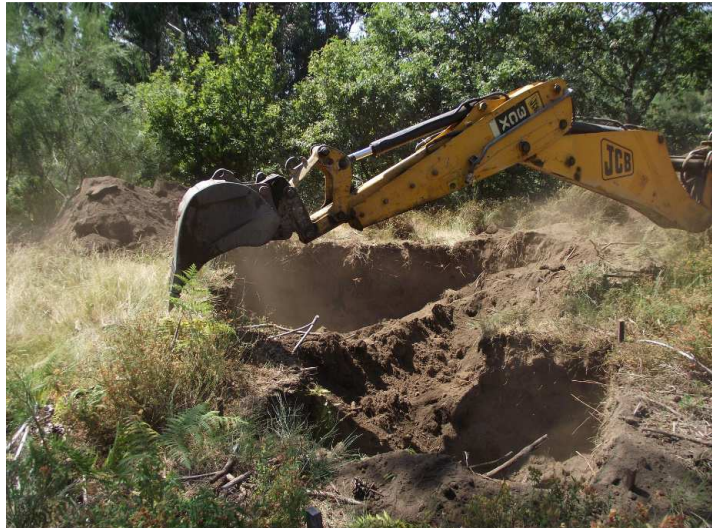
SET - Escavação do cabouco do AP 47.
