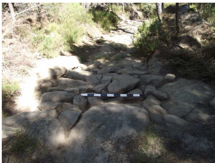
SET - Vista geral do troço de calçada limpo.
