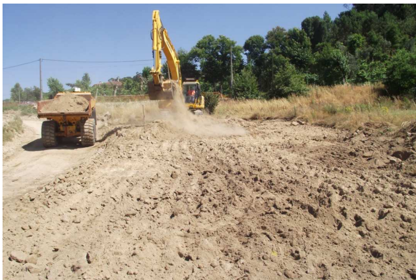
SET| Decapagem da área de estaleiro.
